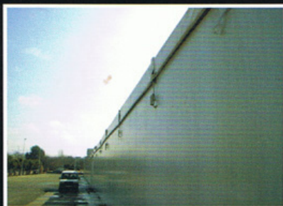
Cerramiento vertical con panel sandwich
