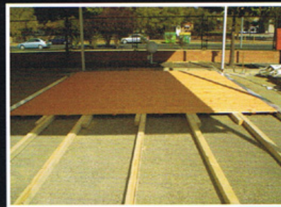
Instalación suelo de madera
