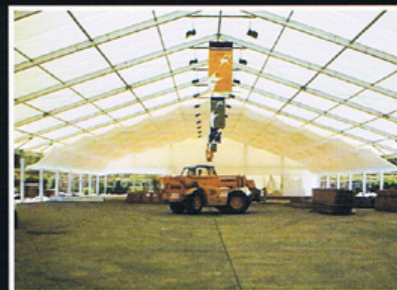
Instalación de doble techo
