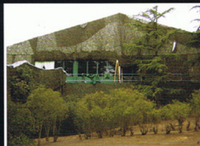
Instalación de sobrecubierta
