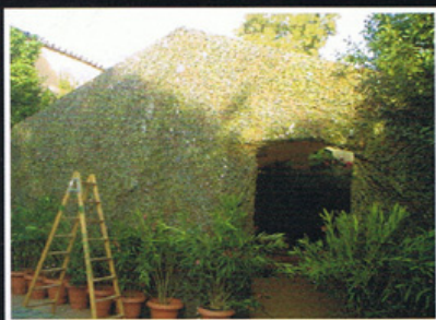
Instalación de sobrecubierta
